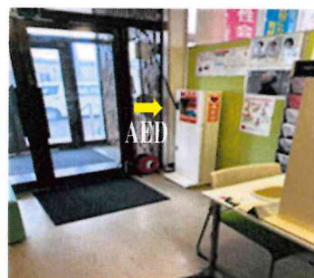
AED 設置状況
