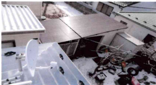
屋根の葺き替え工事
